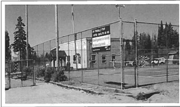
Le garage municipal et le tennis.
