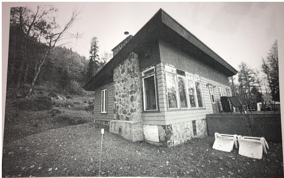
EXISTANT- FAÇADE LATÉRALE GAUCHE
