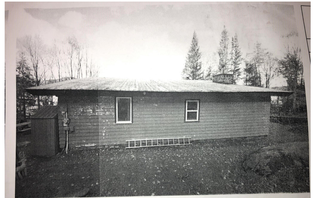
EXISTANT- FAÇADE ARRIÈRE
